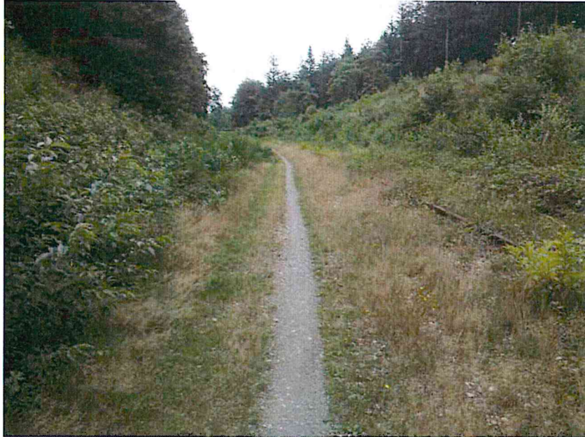
Figuur 1.2. Foto van het plangebied west van de brug over de spoorkuil kijkend naar het oosten. De brug is op de foto in de verte zichtbaar. Aan de rechterzijde van de foto ligt de spoorrails.
